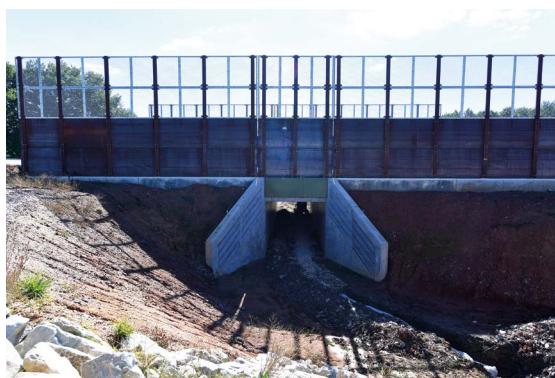
Passage piétons/cyclistes au Pas du Rieu
