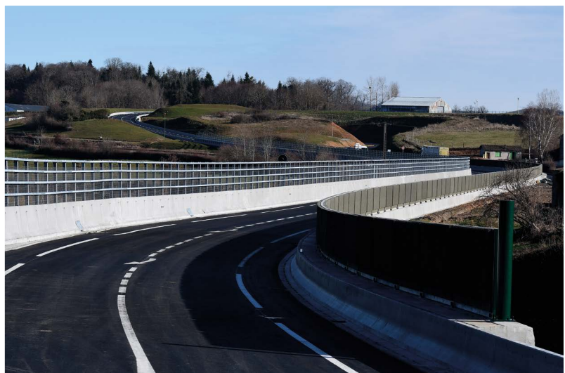
Protection des voies SNCF et mur anti-bruit
