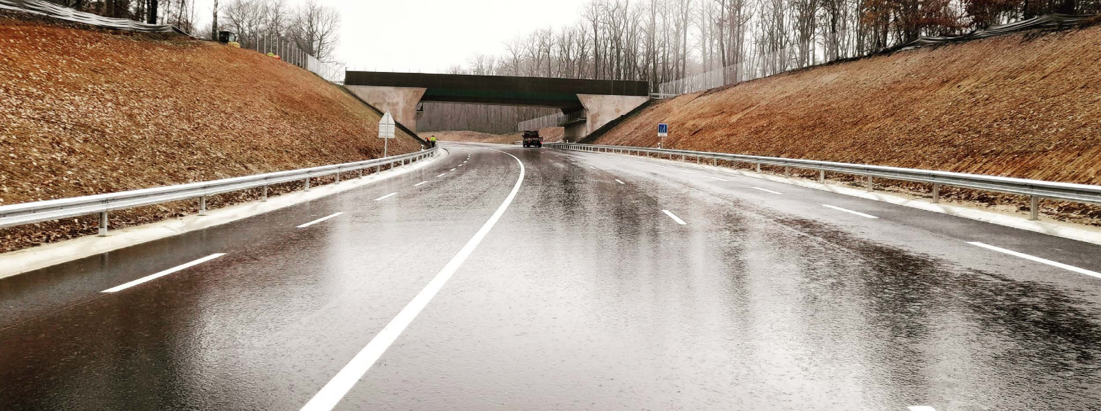
Passage supérieur route d'Ytrac
