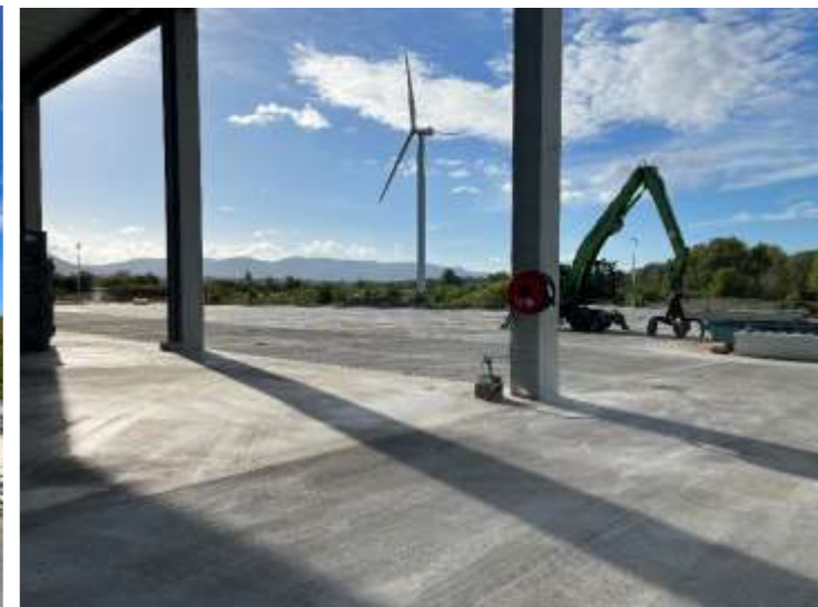
Plateforme SOLUWASTE : exemple de dispositif du réseau d'extinction incendie dans partie ouverte du bâtiment (cliché TS 09/22)
