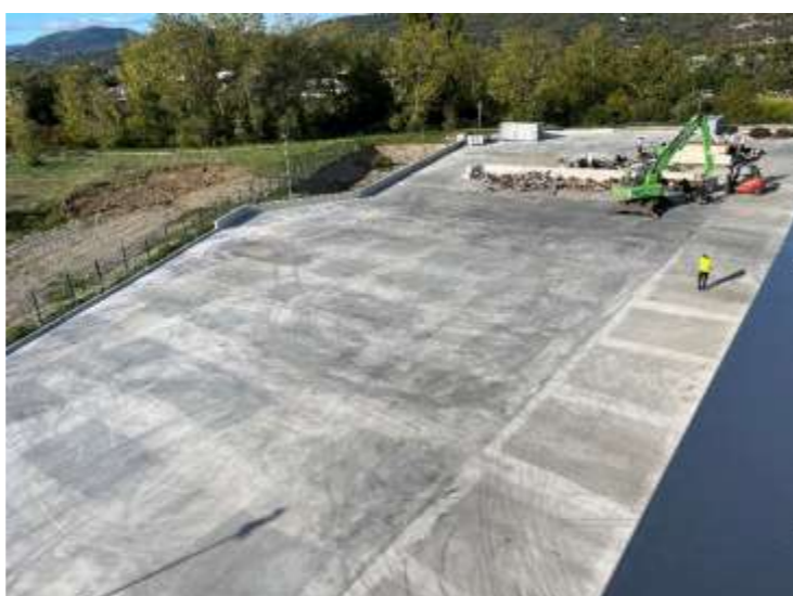
Plateforme SOLUWASTE : angle sud-ouest de l'aire bétonnée de stockage des déchets, bassin de rétention/infiltration vus depuis le toit du bâtiment vers le sud-ouest (cliché TS 09/22)
