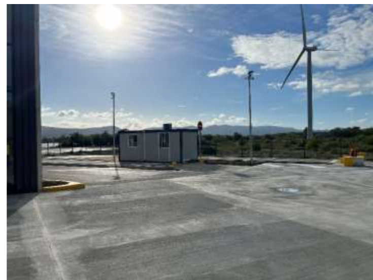
Plateforme SOLUWASTE : la plateforme est totalement clôturée et équipée de mâts avec dispositif de vidéosurveillance en permanence (cliché TS 09/22)
