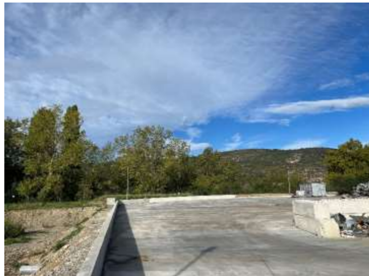
Plateforme SOLUWASTE : angle sud-ouest de l'aire bétonnée, bassin de rétention/infiltration en cours d'enherbement et muret béton délimitant l'aire de rétention des eaux pluviales et des eaux d'extinction incendie (cliché TS 09/22)
