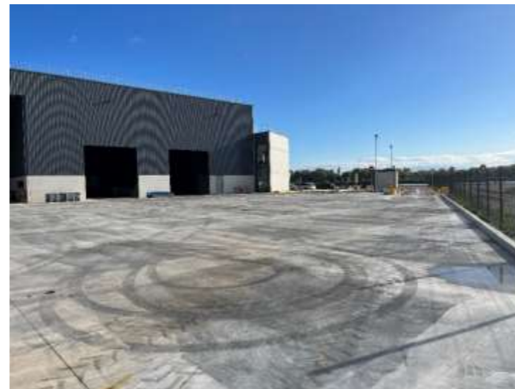
Plateforme SOLUWASTE : bâtiment partie totalement fermée vue depuis l'aire bétonnée de stockage des déchets vers l'entrée du site (cliché TS 09/22)
