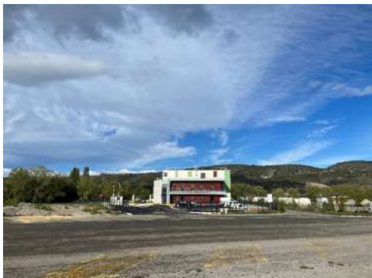
Entrée de la plateforme SOLUWASTE et de la rue du port vues depuis le quai fluvial sur la façade bureaux (cliché TS 09/22)
