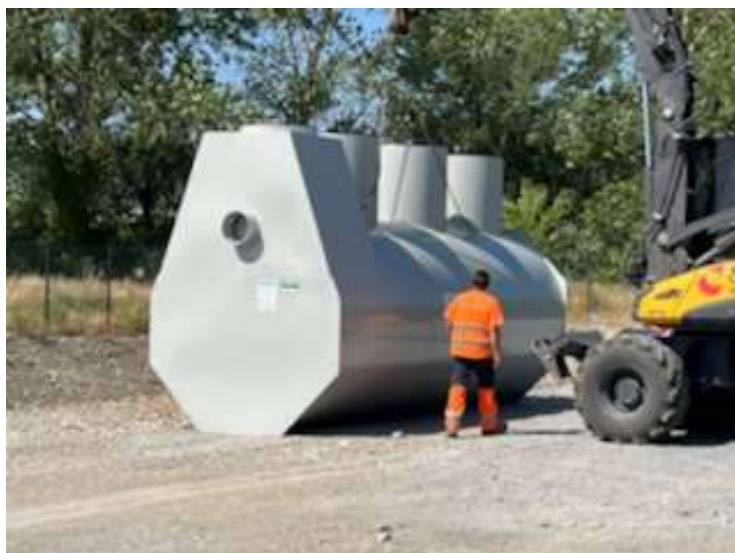
Plateforme SOLUWASTE : débourbeur/séparateur d'hydrocarbures sur le site avant sa mise en place (cliché TS 09/22)
