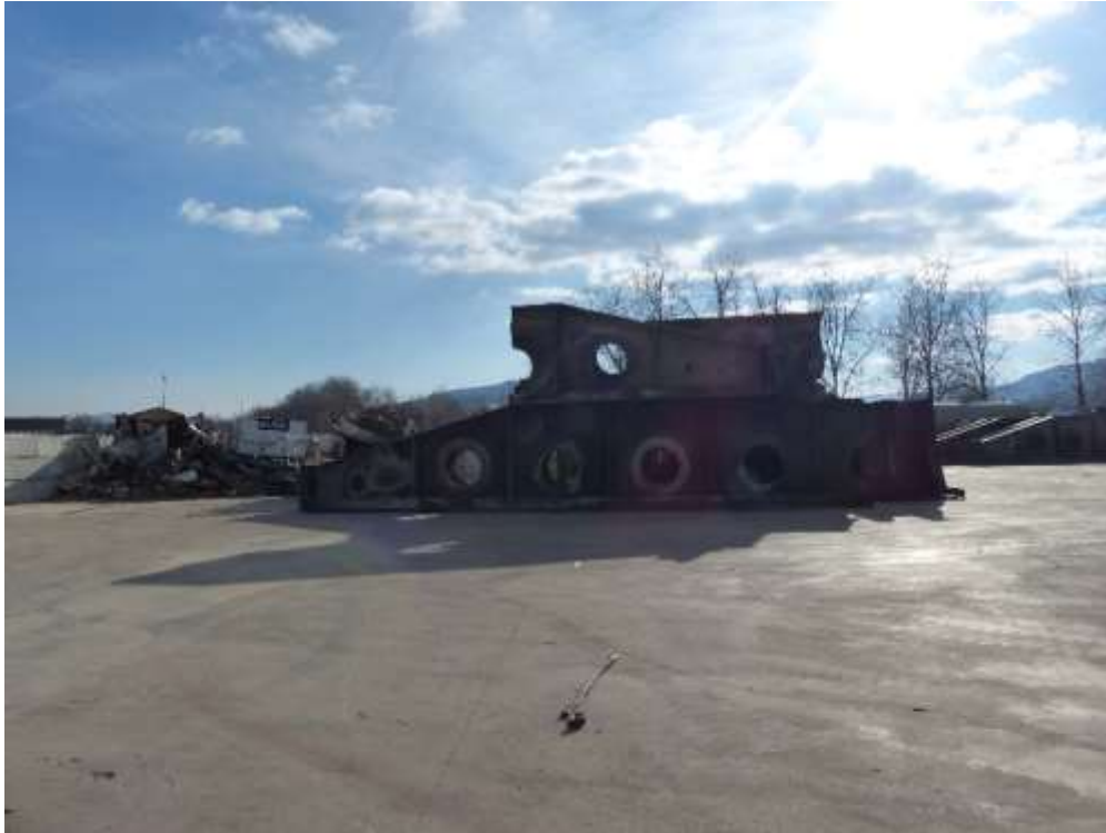
Figure 2 : Exemple de poutrelles métalliques à découper nécessitant une organisation particulière temporaire de la surface bétonnée de stockage (cliché février 2023)
