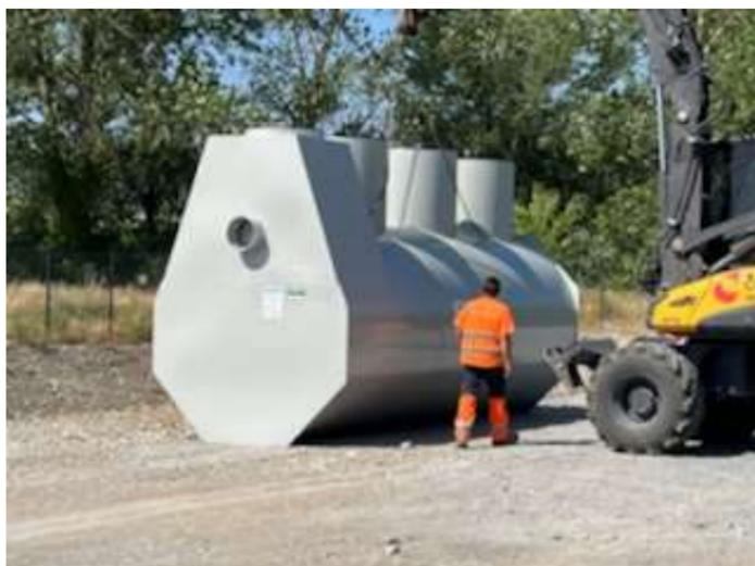
Plateforme SOLUWASTE : déboureur/séparateur d'hydrocarbures sur le site avant sa mise en place (cliché TS 09/22)
