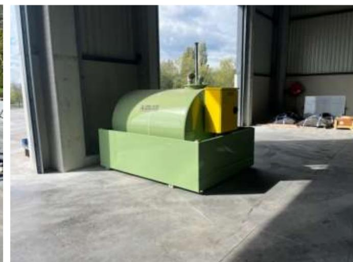
Plateforme SOLUWASTE : Stockage de 3000 l d'hydrocarbures et pompe de distribution sur cuvette de rétention elle-même sur dalle étanche, sera placée dans la partie fermée du bâtiment (cliché TS 09/22)
