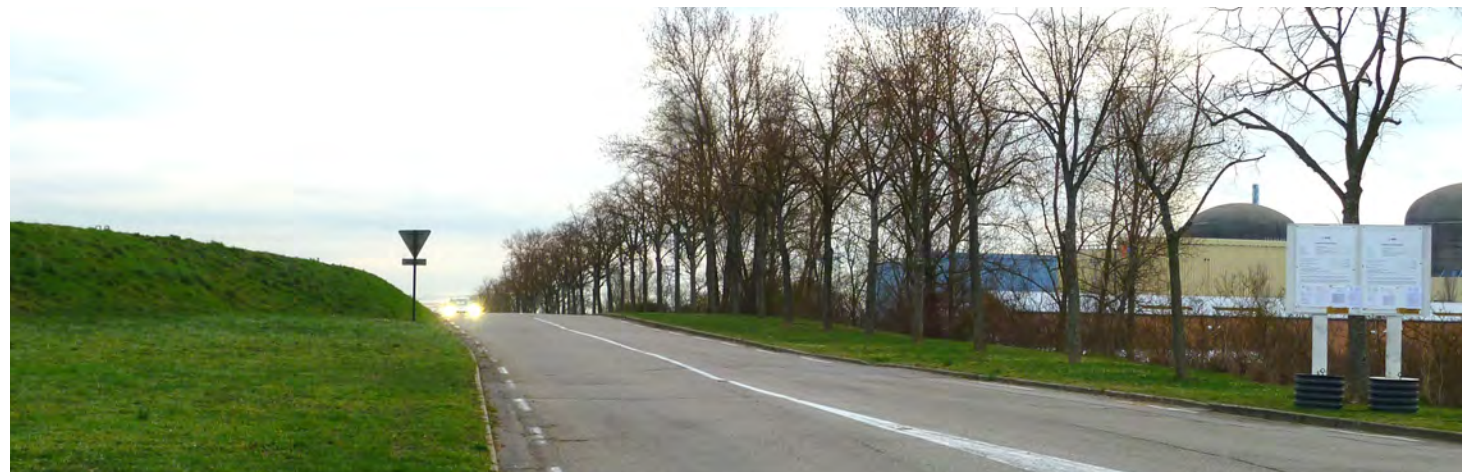
PC 8.1 - Vue sur l'entrée du site du CNPE
