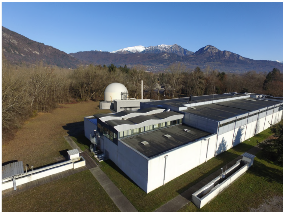
Vue aérienne Sud-Ouest
