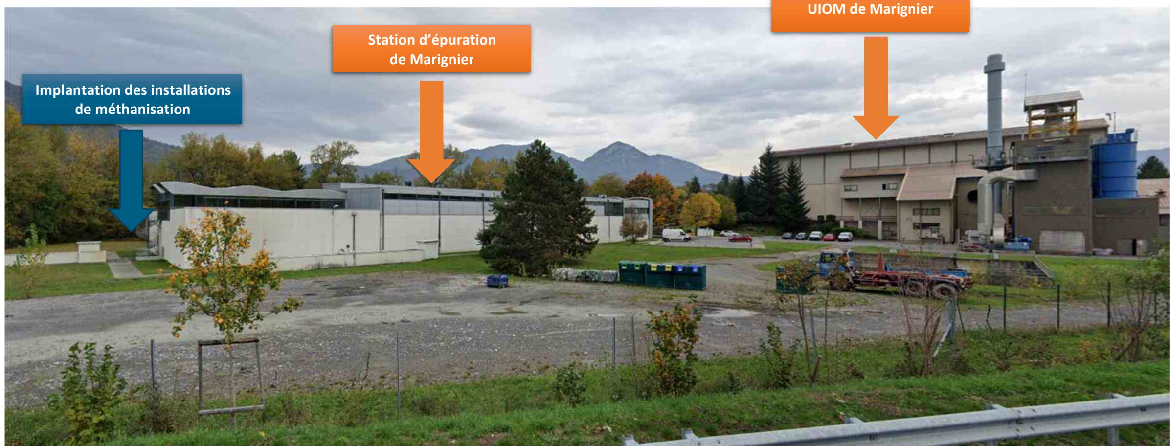
SITE DU PROJET VU DEPUIS LE CONTOURNEMENT DE MARIGNIER (ENVIRONNEMENT LOINTAIN)
