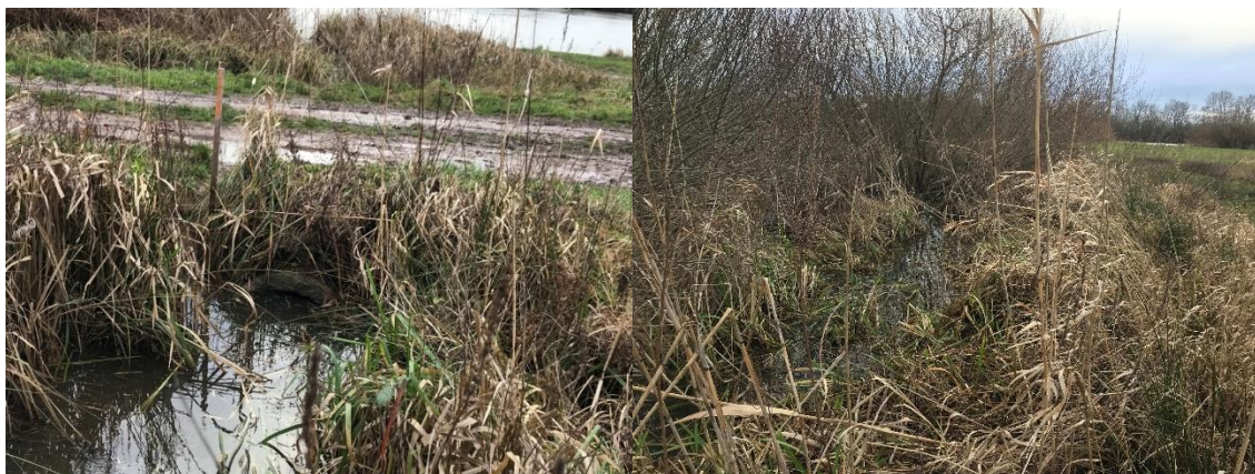
Vue de la buse et du fossé
