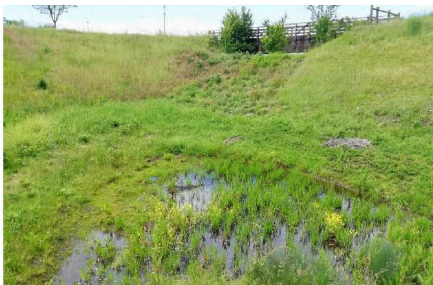
Figure 25 : Bassin d'infiltration, H. Elie © EODD 2021
