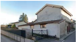
> La ferme réhabilitée le long de la route de Noailleux
