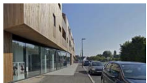
> Traitement des socles actifs SABH - Ecoflant
