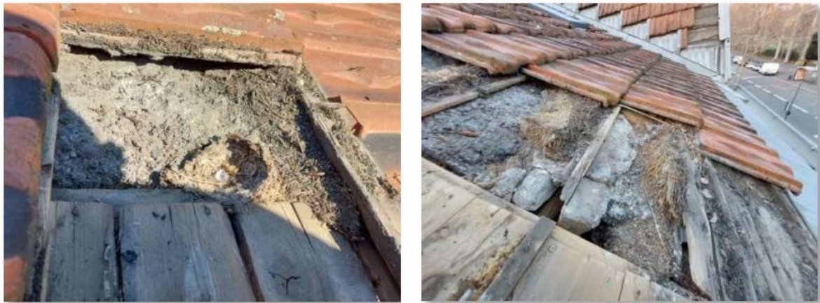
Figure 18 : Détuillage ayant permis de découvrir des nids de martinets et de moineau lors d’une opération de mise en défens dans la commune de Villeurbanne.
