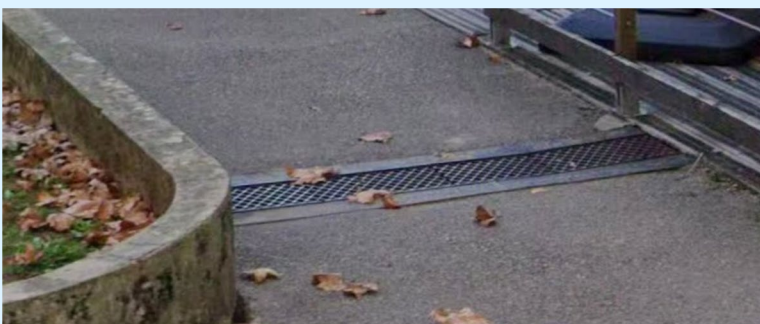
Muret guidant vers une grille de gestion des eaux pluviales (passage obligé vers un piège) et muret de clôture en fond de parcelle
