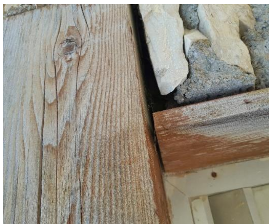
Photo 8 : Anfractuosités dans le bâtiment de la station d'épuration actuelle
