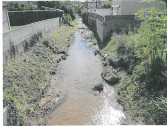
Vue du tronçon aval depuis sa limite amont
