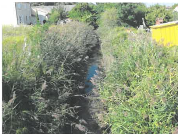
Vue du tronçon intermédiaire depuis sa limite aval
