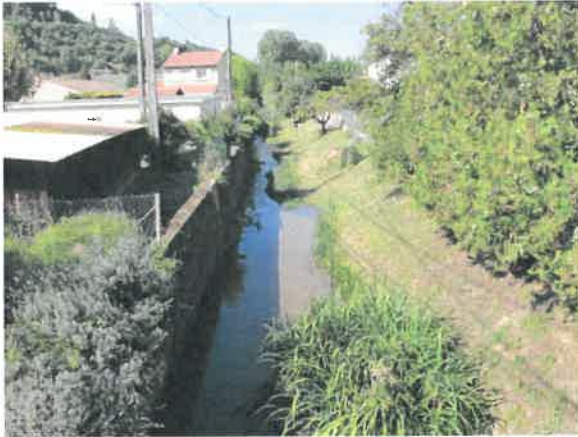
Vue du tronçon aval depuis le pont
