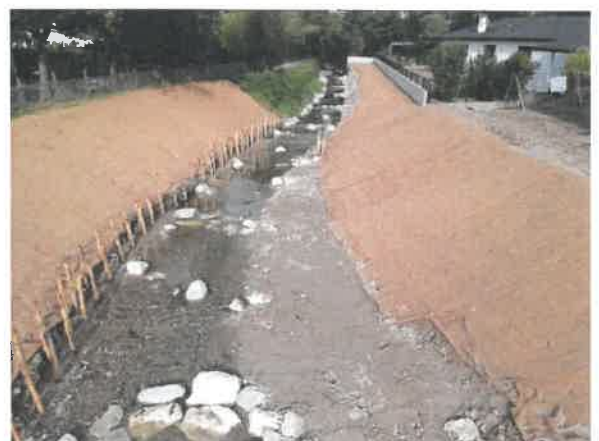
Retalutage, plantation et diversification du lit
