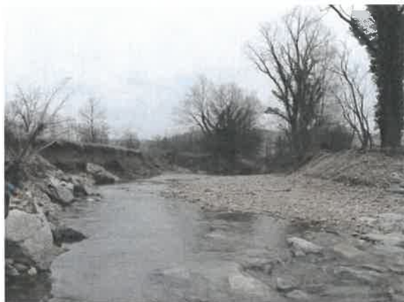
Erosion de berge sur la Limone
