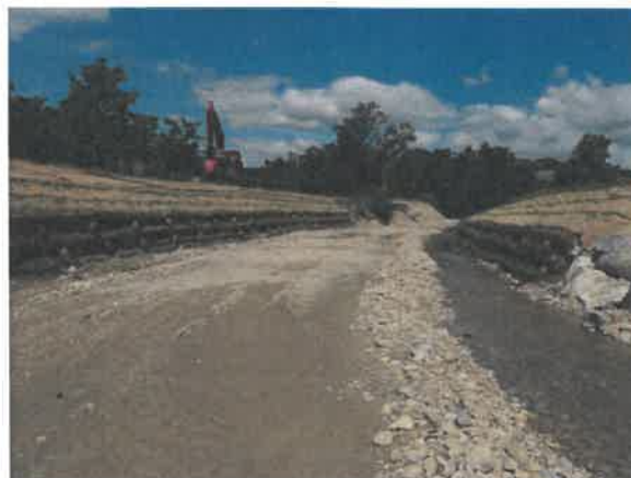
Mise en place de caissons végétalisés par le SIABH
