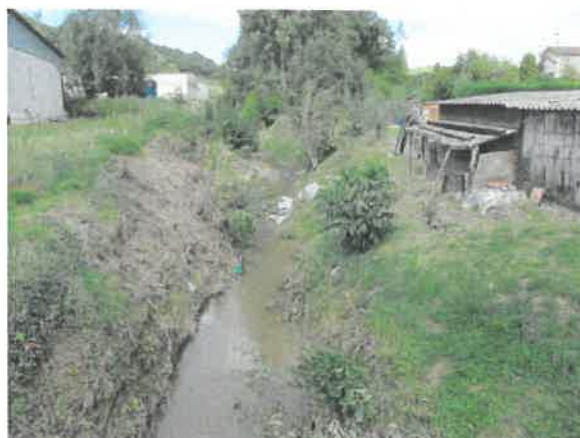
Vue du tronçon intermédiaire depuis sa limite amont
