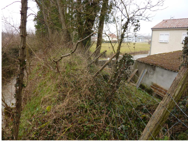
Habitation située en bordure rive droite de la digue du Nant
