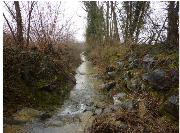
Seuil aval du piège à graviers
