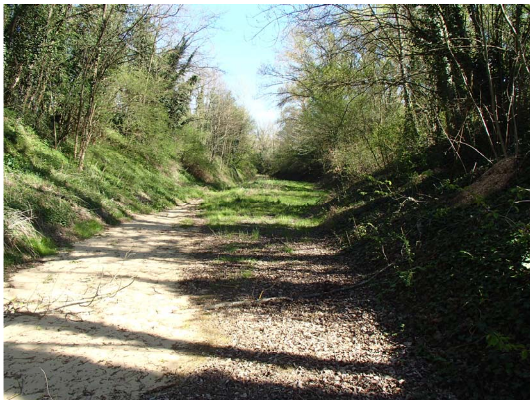
VUE N°12 : LIT DU NANT – SECTEUR AMONT DE LA ZONE DE TRAVAUX
