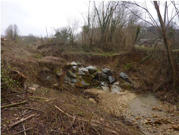
Seuil amont de la zone d'étude
