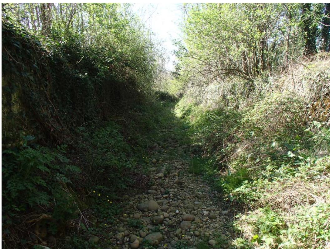
VUE N°11 : LIT DU NANT – SECTEUR INTERMEDIAIRE DE LA ZONE DE TRAVAUX
