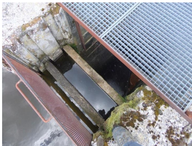
Figure 15 : bastaings et grille métallique
