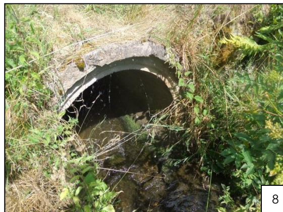
Franchissement sous la route
