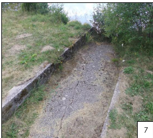
Evacuateur de crue
