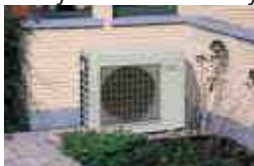
Ci-contre, un groupe extérieur de PAC aérothermique.
