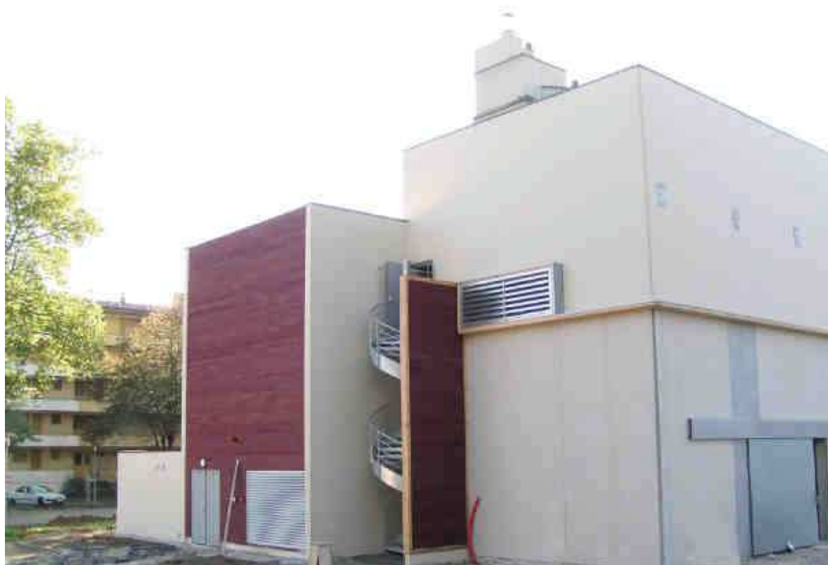
Chaufferie bois – Bourg en Bresse – Ain (01)
