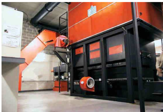
Ci-contre : Chaufferie 220 kW avec conteneur à cendres
