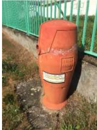
FIGURE 9 : POTEAU INCENDIE SITUÉ EN FACE DE L'ENTRÉE DU SITE
