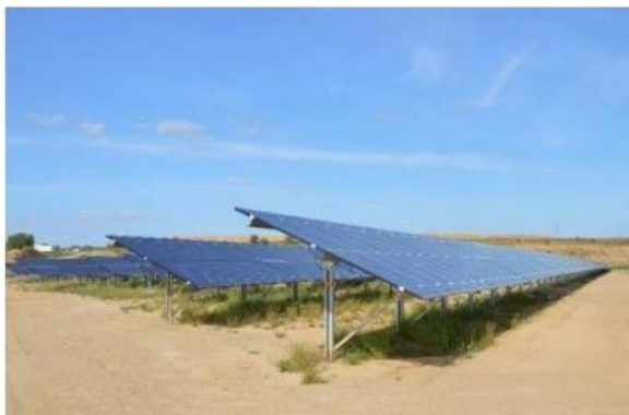
Figure 11 : Exemples de structures fixes et fondations par la méthode des pieux battus
