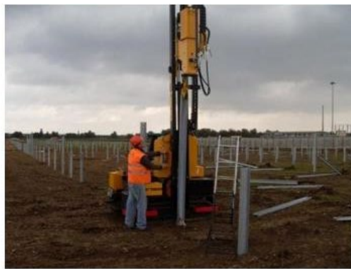
Figure 11 : Exemples de structures fixes et fondations par la méthode des pieux battus
