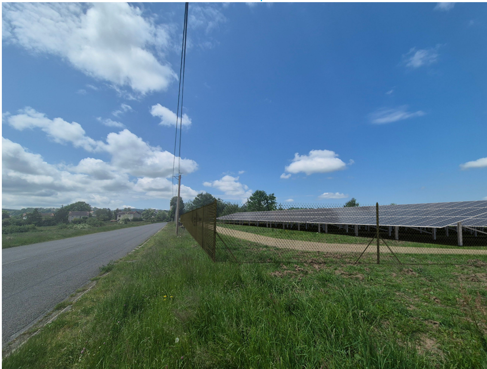
État Projet – Photomontage sans insertion paysagère depuis la Rue du Puits du Manoir au Sud (source : HOCH, 2025)
