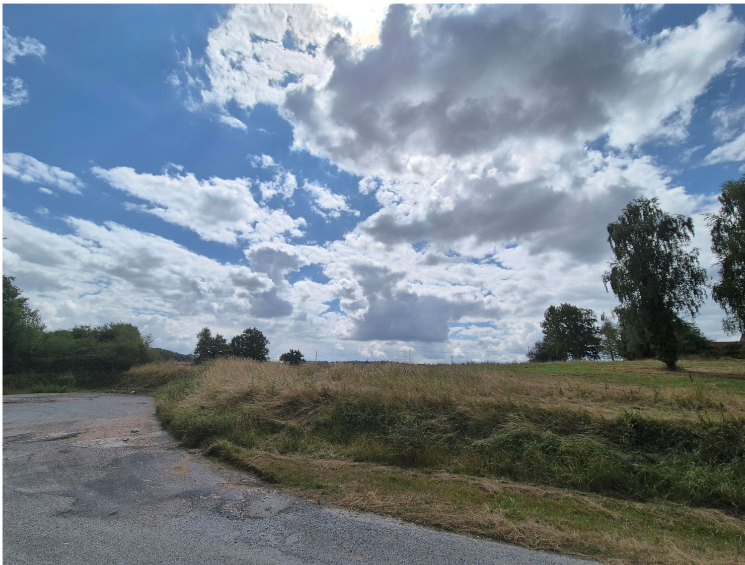
État initial – Emplacement du futur portail depuis le chemin d'accès au Nord
