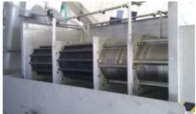
Zone d'épaississement PEHD et de pressage INOX
