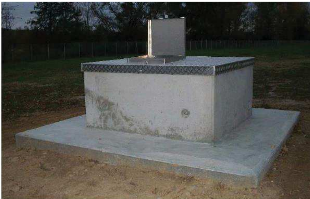
Regard de forage
