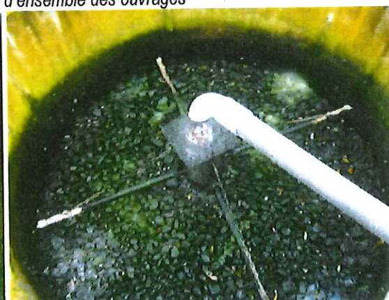
Décanteur/digesteur et lit bactérien avec grille sur l'alimentation du sprinkler
