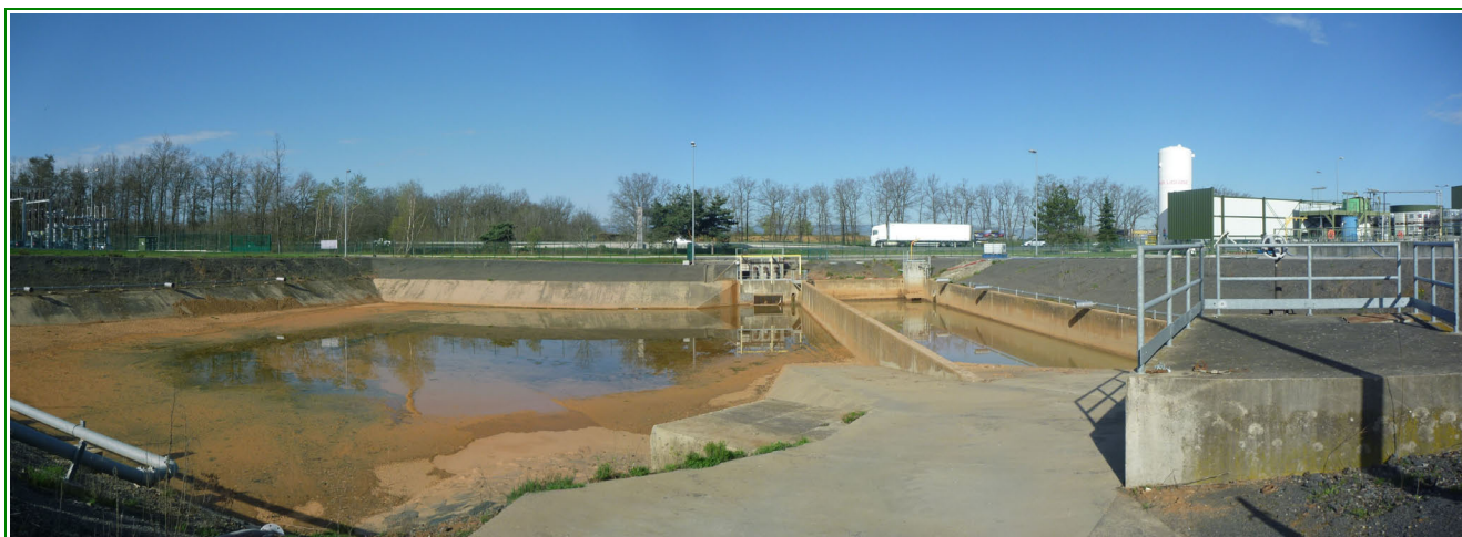
Bassin de gestion des eaux pluviales sur le site SNF
