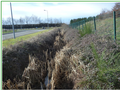
Fossé EP ZA de l'Orme
