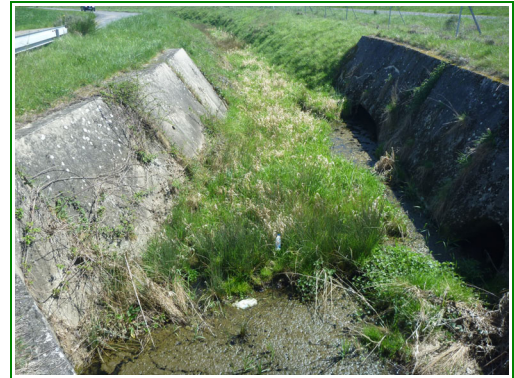
Ruisseau Sans Nom - Aval aéroport
