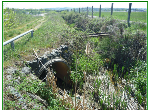
Rejet réseau EP ZA dans ruisseau Sans Nom
