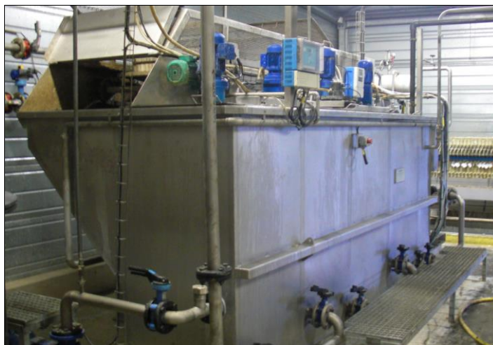
Station de traitement physico-chimique
