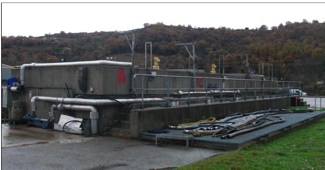
Exemple de bassin d'homogénéisation
