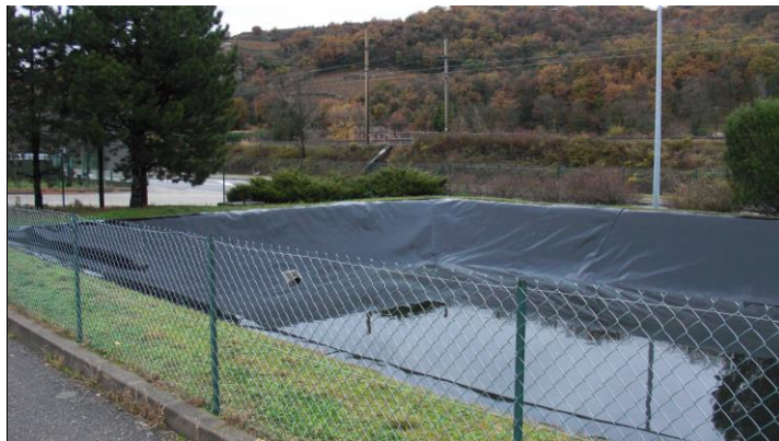
Exemple de bassin de rétention
