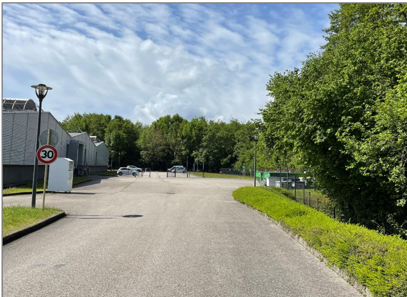
Vue 3 (prise le 18 mai 2021) : façade Ouest du bâtiment qui fera l'objet de l'extension atelier coupe et stockage de peaux à la place du parking de stationnement des véhicules du personnel et de la cour camion
