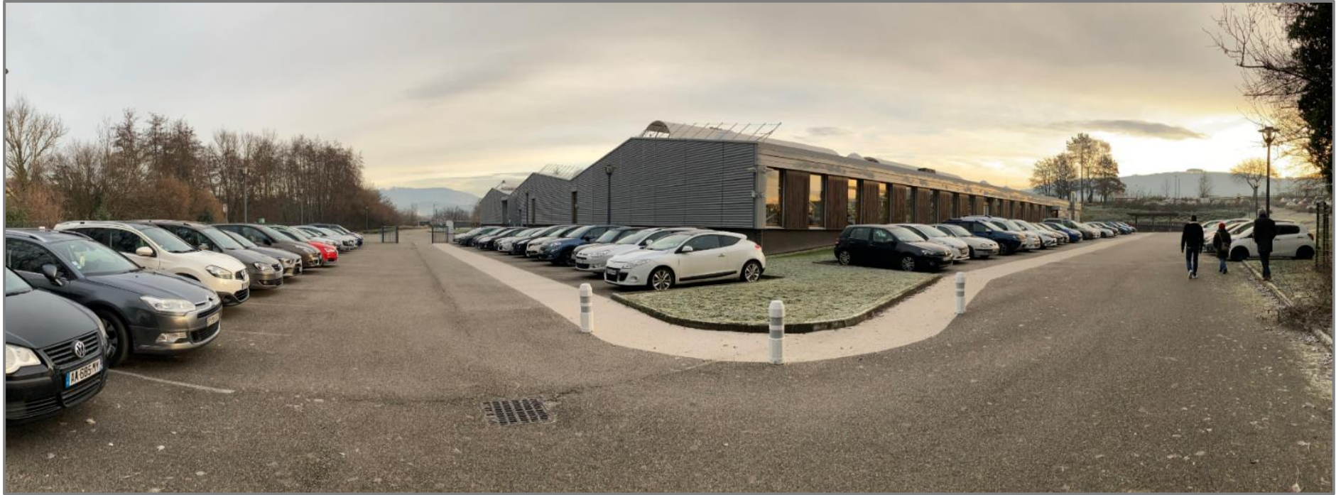
1 : Vue depuis la voie intérieure du site, vers le bâtiment existant, vue sur la façade Ouest et la façade Sud qui feront l'objet de l'extension, les places de stationnement seront remplacées par les extensions du bâtiment
