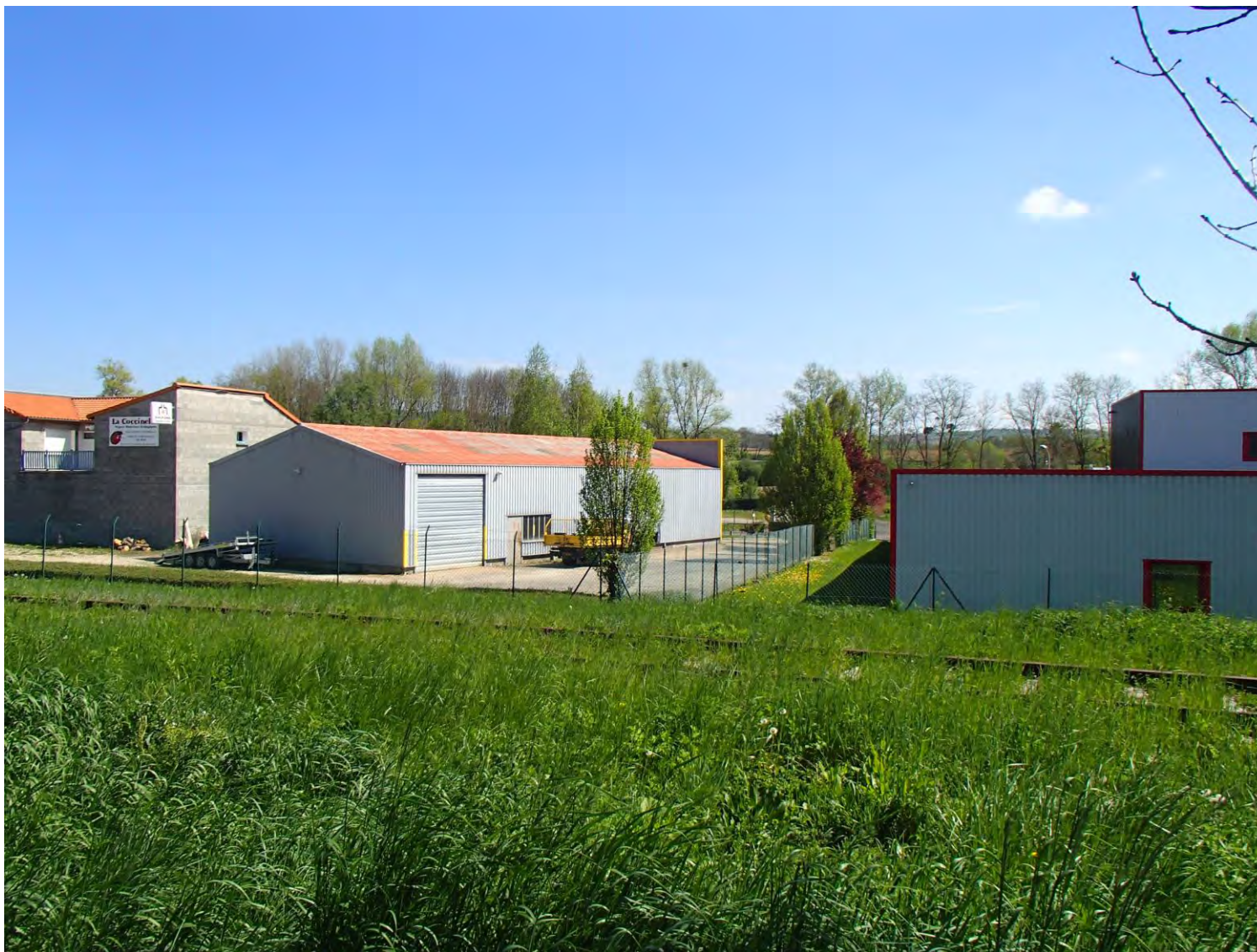
6 – Vue sur les bâtiments d'activités de la ZA de l'Angaud (vue de l'Ouest vers l'Est) avec au premier plan l'ancienne voie ferrée Billom/Vertaizon
