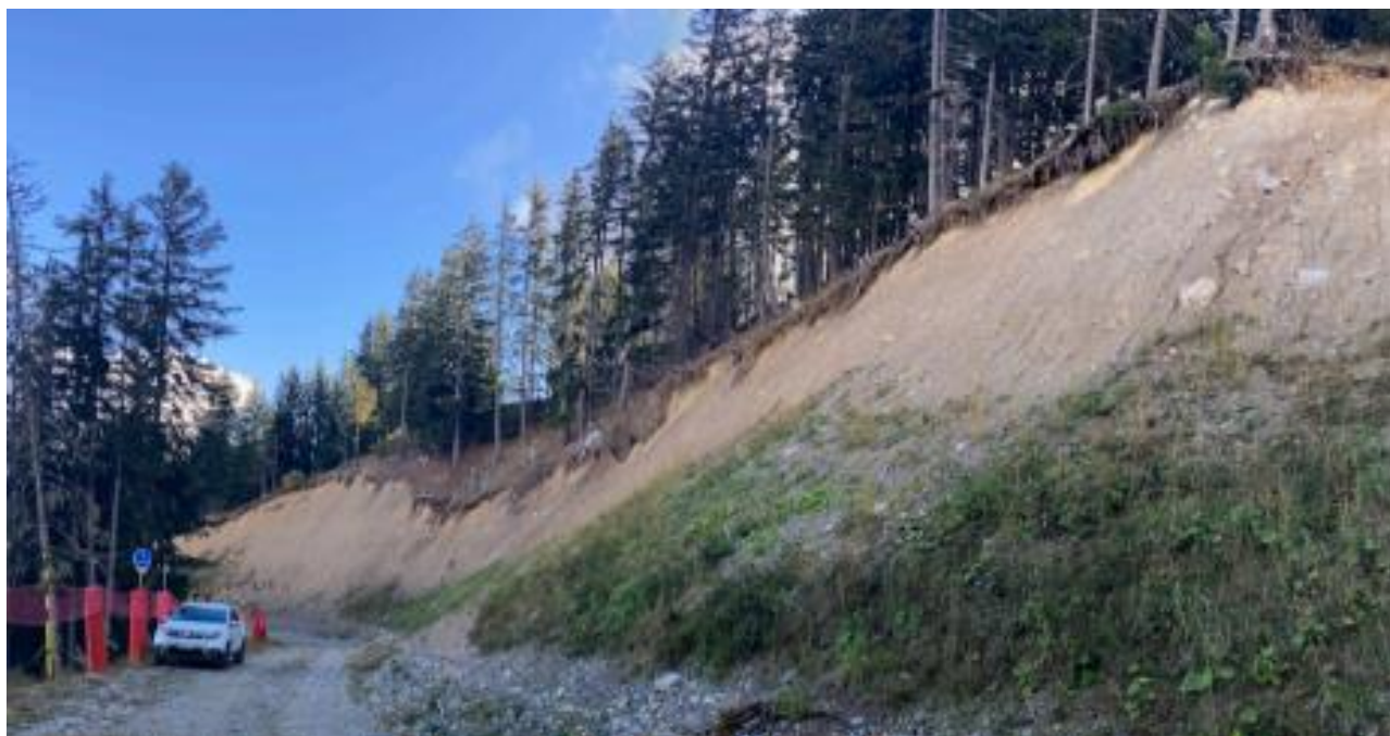
VUE GENERALE DU TALUS ETUDIE
