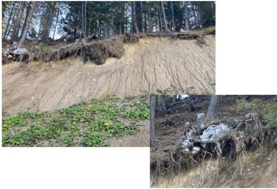
VUES DE LA NICHE D'ARRACHEMENT : RISQUE IMPORTANT DE DEPART DE BLOCS A COURT/MOYEN TERME
