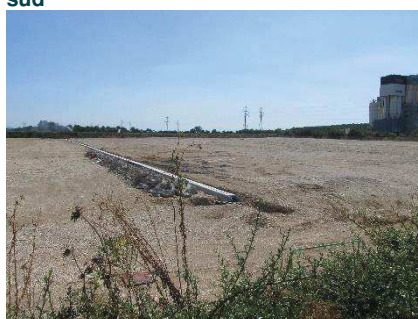
Secteur ouest avec travaux en 2018, l'habitat de l'Œdicnème a disparu
