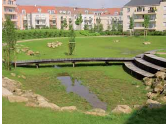
Exemple de bassin de rétention paysager
