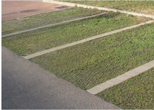
Exemple de places de parking enherbées non étanches
