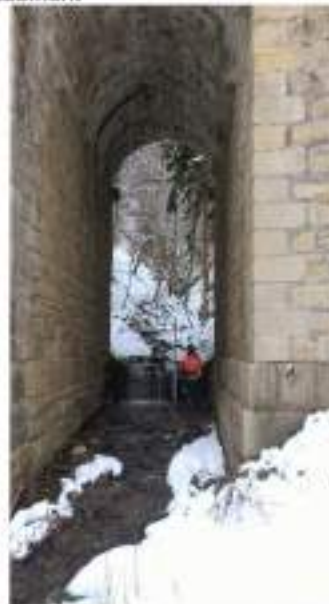
4- Chute ancien OA à 50 mètres à l'amont du franchissement
