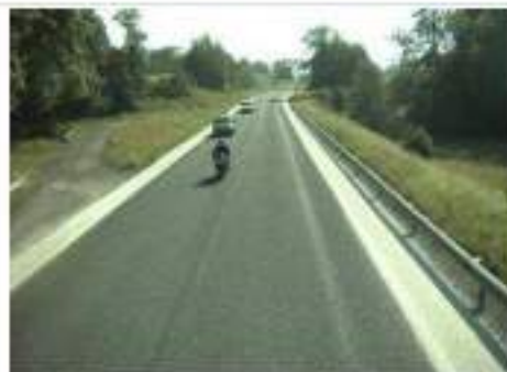
délaissé existant pour le franchissement du Pie
