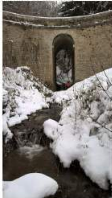
2- Vue vers l'amont du franchissement (chute infranchissable de 0.8 mètre)
