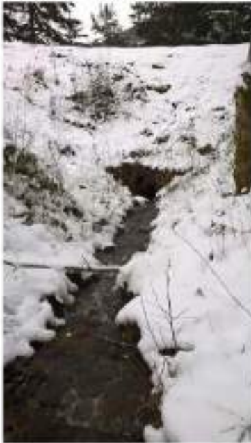
1- Franchissement de la RN 122 vu depuis l'amont
