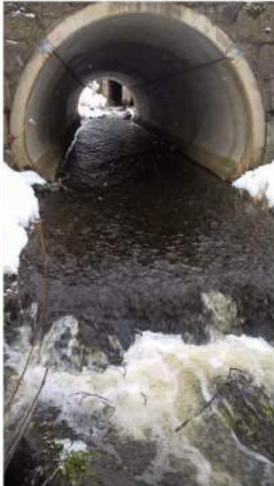
4- Vue du radier du busage de la RN 122 et de la chute aval
