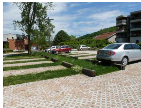
. Le parking mutualisé : perméabilité des matériaux de sol
