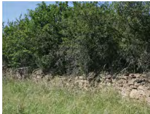
. Muret en pierre sèche en limite de site.
