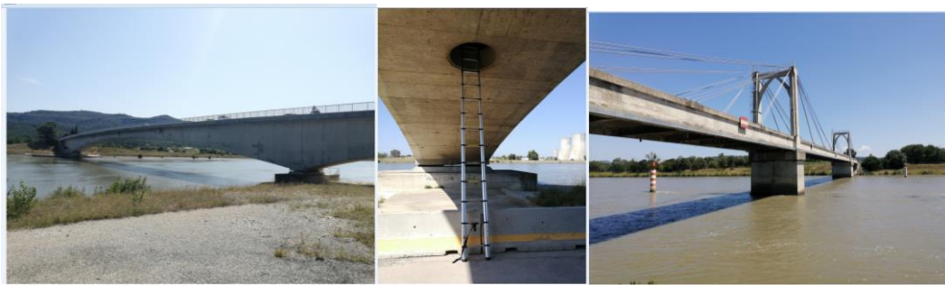
Figure 17. Inspection d'ouvrage d'art dans le cadre de l'étude IFF3 (pont de Tricastin à gauche)
