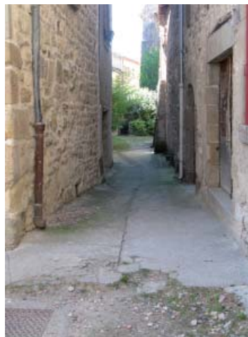
Ruelle dans le fort avant et après la restauration récemment réalisée.
