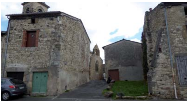
L'esplanade de l'église n'est pour l'instant pas mise en valeur. La question du traitement de la liaison avec la place du Chapitel autrefois refermée par un bâtiment devra être réfléchi.
