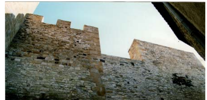
Porte intérieure du fort vieux après restauration
