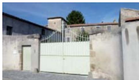
domaine agricole au centre du bourg : chaque élément de l'ensemble est conservé dans sa volumétrie et ses détails
