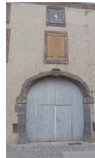
encadrements en lave sur une façade datée de 1878
