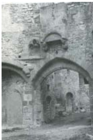
La porte Saint-Jean avant restauration (cliché Jean Bertachon, in DUICKER)
