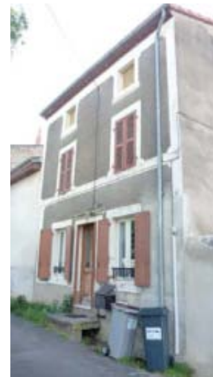
rue du Tabot parcelle 848 petite maison à trois travées
