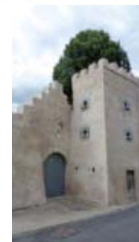
vestiges de la chapelle (parcelle 1642)
