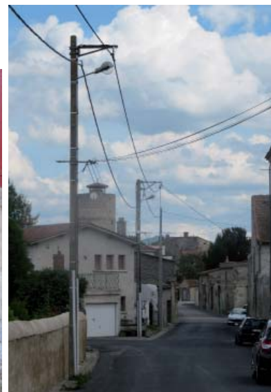
La rue du 8 mai avant les travaux de rénovation qui ont permis d'enterrer les réseaux aériens.
