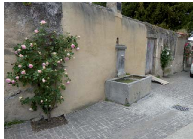
La rue du 8 mai et la rue de la Mairie sont les deux axes principaux de la Sauvetat qui ont fait l'objet d'une rénovation récente. La bande de roulement en enrobé grenailé a été réduite et remplacée sur des rives par des petits pavés basaltiques. Ils mettent en valeur les placettes, les façades et le petit patrimoine tout en délimitant l'espace piétonnier.
