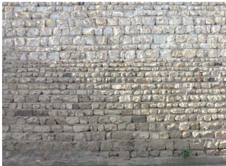
moellons de calcaire et joints «beurrés»: des maçonneries de très grande qualité
