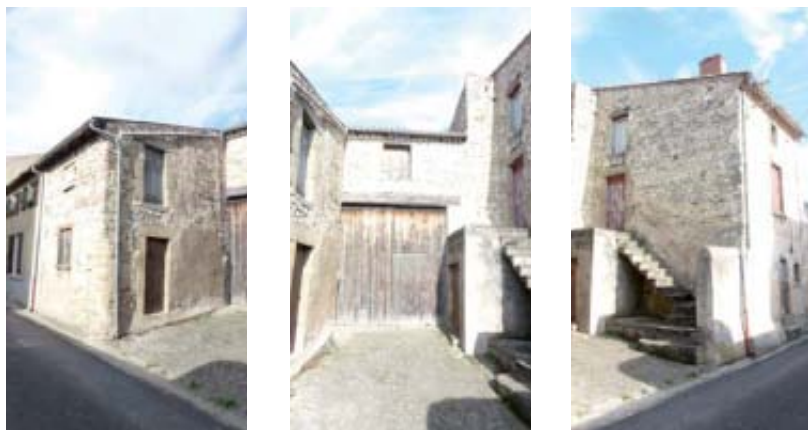
dépendances agricoles et petite maison vigneronne disposées en U autour d'une cour : typiques des petites fermes et non transformées
