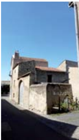
rue du 11 Novembre bâtiments regroupés autour d'une petite cour parcelle 740
