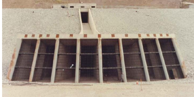
Figure 2 : Photographie de la prise d'eau du bassin du Flumet en fin de construction
