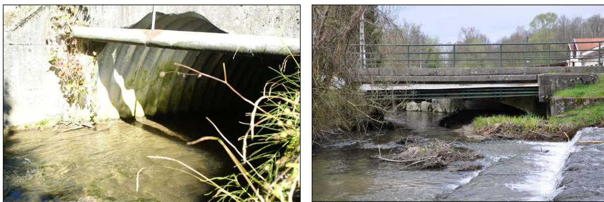
Ouvrage sous la RD82 et pont de la RD 1516
