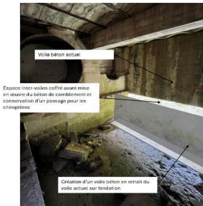
Figure 6 : Principe de mise en œuvre des voiles béton
