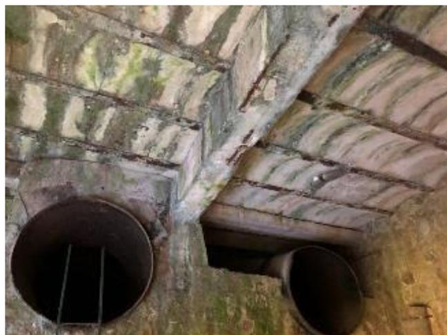
Figure 7 : Ancienne conduite forcée à condamner avant mise en œuvre du béton.
