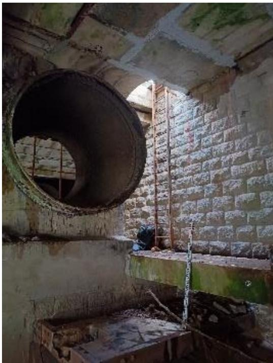
Figure 10 : Espace sous dalle actuellement étayé qui sera comblé au béton
