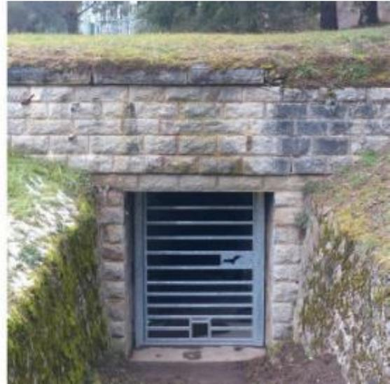
Figure 26 : Entrée de la cavité de report initialement hermétique aux chauves-souris (gauche) remplacée par une grille perméable aux Chiroptères (droite)
