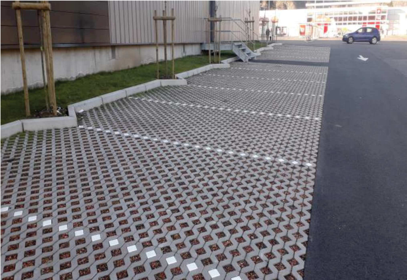
Exemple de traitement de sol de parking en système ECOVEGETAL
