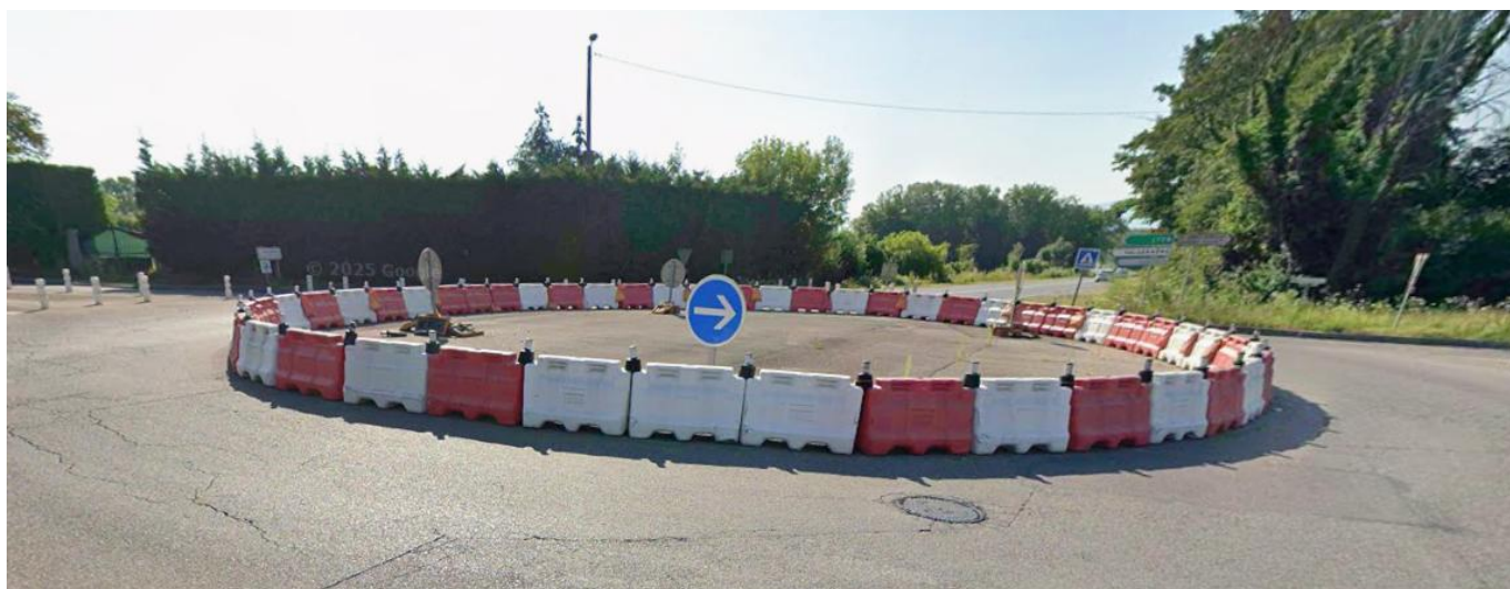
Figure 3 : Giratoire « plastique » RD35a/RD75a (Source : Google maps)
