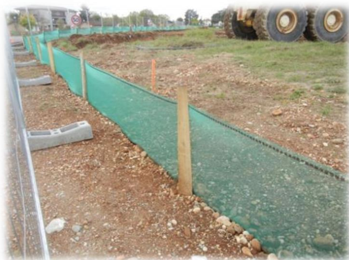
Exemple de bonne installation de la barrière amphibien : bâche tendue (Ecotope)
