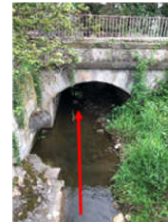
Figure 65 : Vue amont de l'OH100 sur le Ricolin
