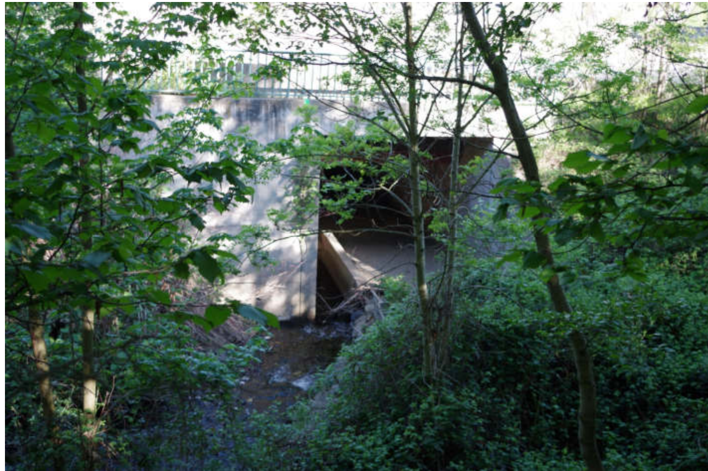
Figure 58 : Ouvrage sous la RN88
