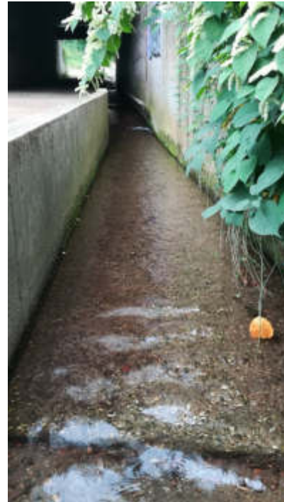
Figure 25 : Radier du pont de la RN88 sur le Janon à 125 en amont de sa confluence avec le Ricolin
