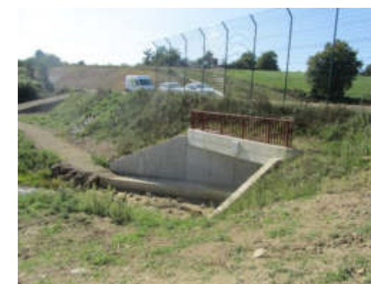
Figure 80 : Exemple de hop-over grillagé avec système de bavolet inversé pour inciter les chiroptères à passer par le passage inférieur
