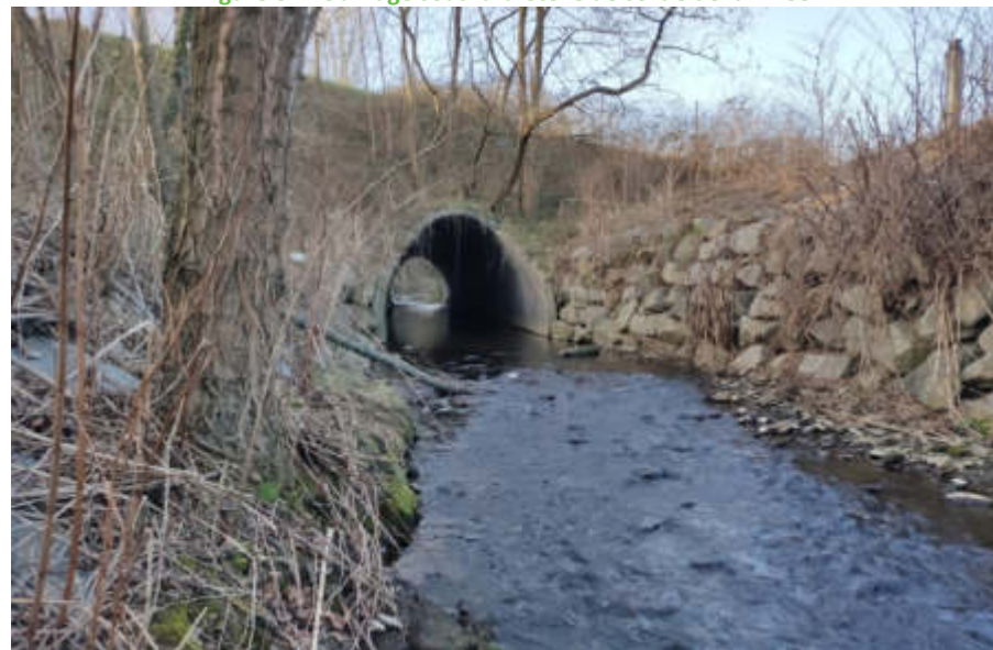
Figure 84 : Ouvrage sous la bretelle de sortie de la RN88
