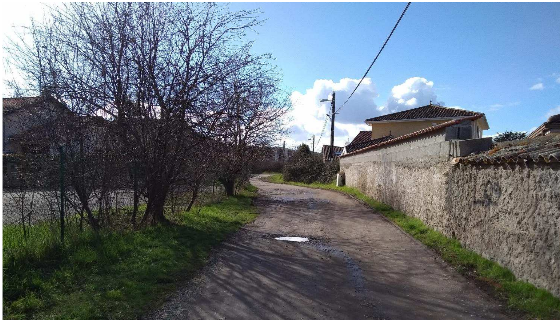
3. Vue de l'impasse de la Voie Romaine (février 2018)
