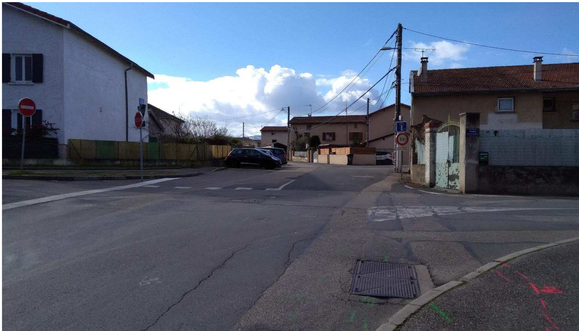
1. Vue de l'impasse de la Voie Romaine au carrefour avec la rue Joachim Gladel (février 2018)
