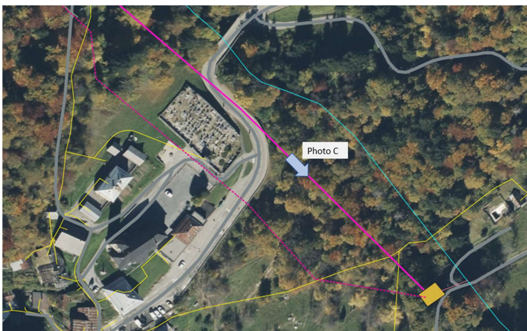
Partie aval de la conduite forcée
