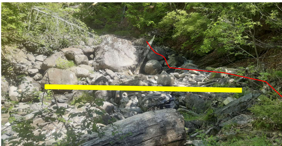
Ancienne prise d'eau
