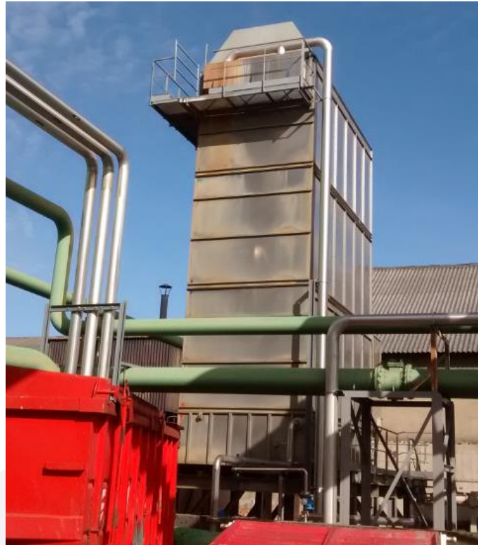
IRDEFA sur le circuit de refroidissement du four FARC
