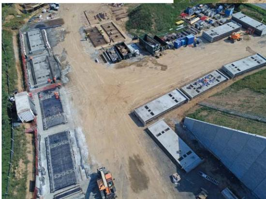
*Préparation des prédalles : coulées sur place et stockées avant leur mise en place sur la charpente métallique*
