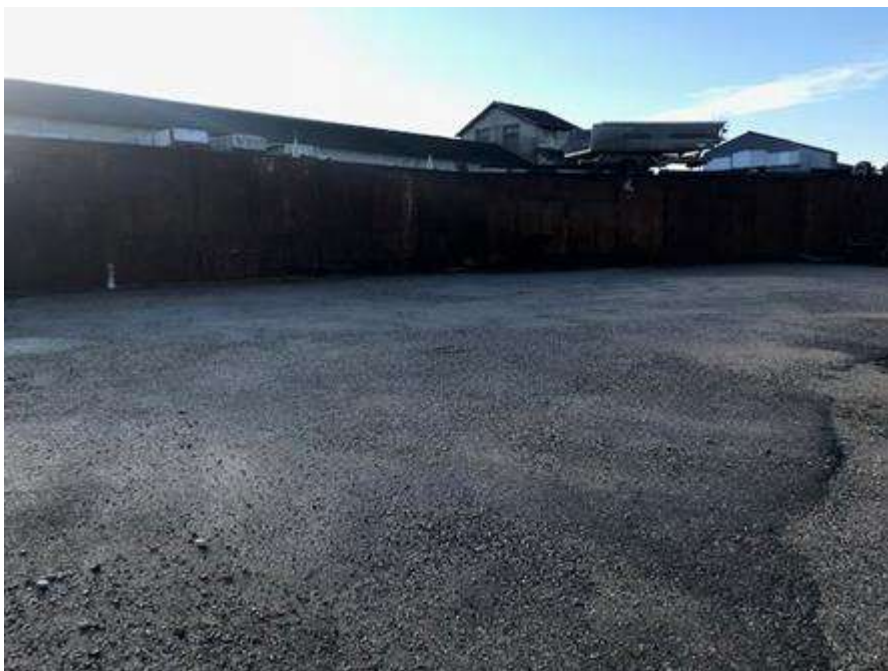
2 - Vue sur la zone enrobée (au Sud de la plateforme) depuis l'entrée du site (22/01/2018)
