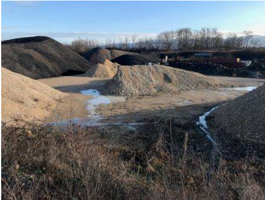
3 - Vue sur la plateforme depuis les silos de chargement en limite de propriété Ouest (22/01/2018)
