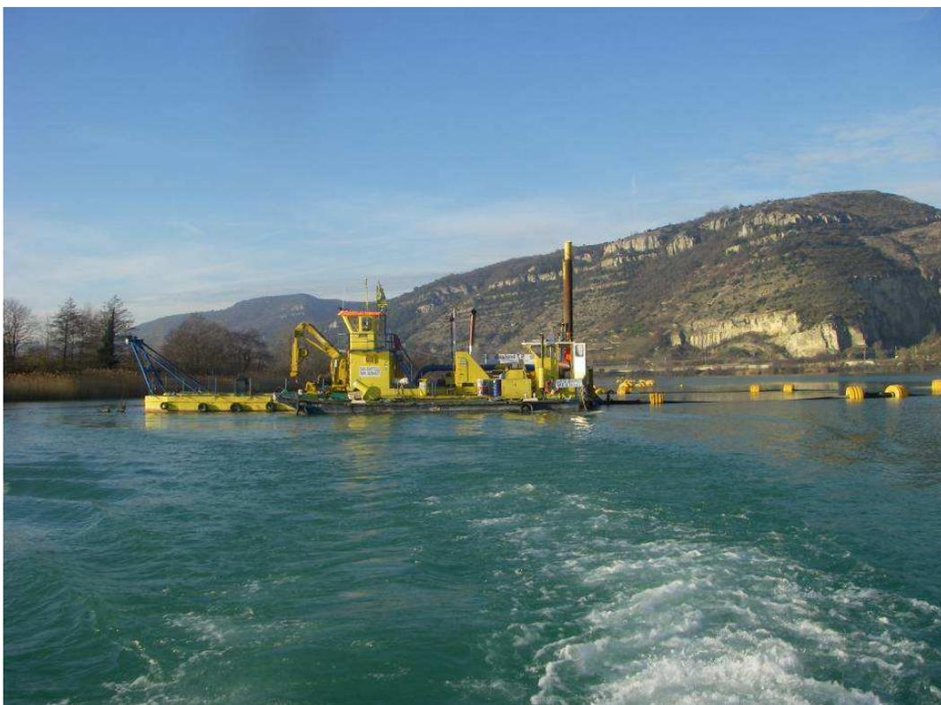
Figure 8 : Exemple de dragage aspiratrice sur la Drôme aval en 2013
