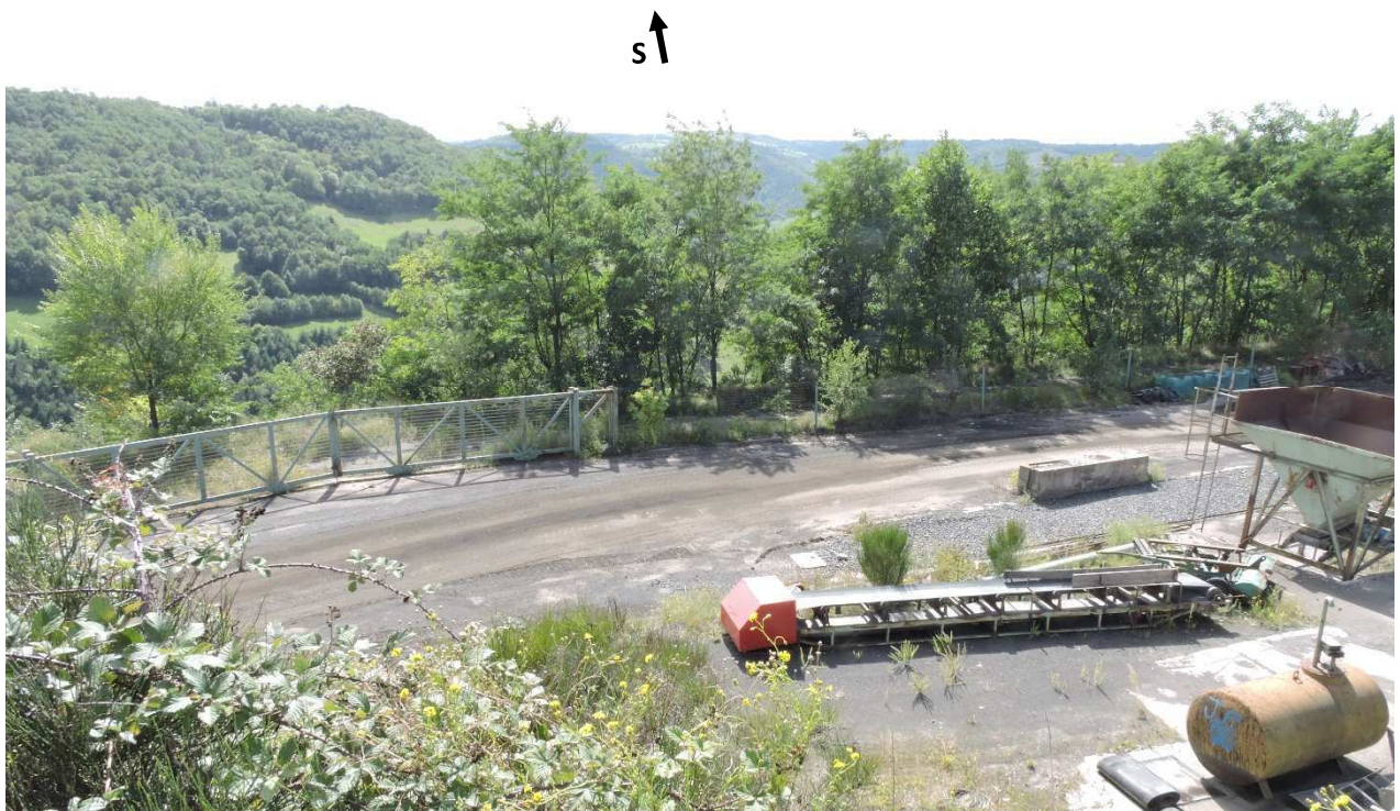
4- Photo prise depuis le nord de la parcelle A 1626, le 14/09/2017, en direction du sud.
