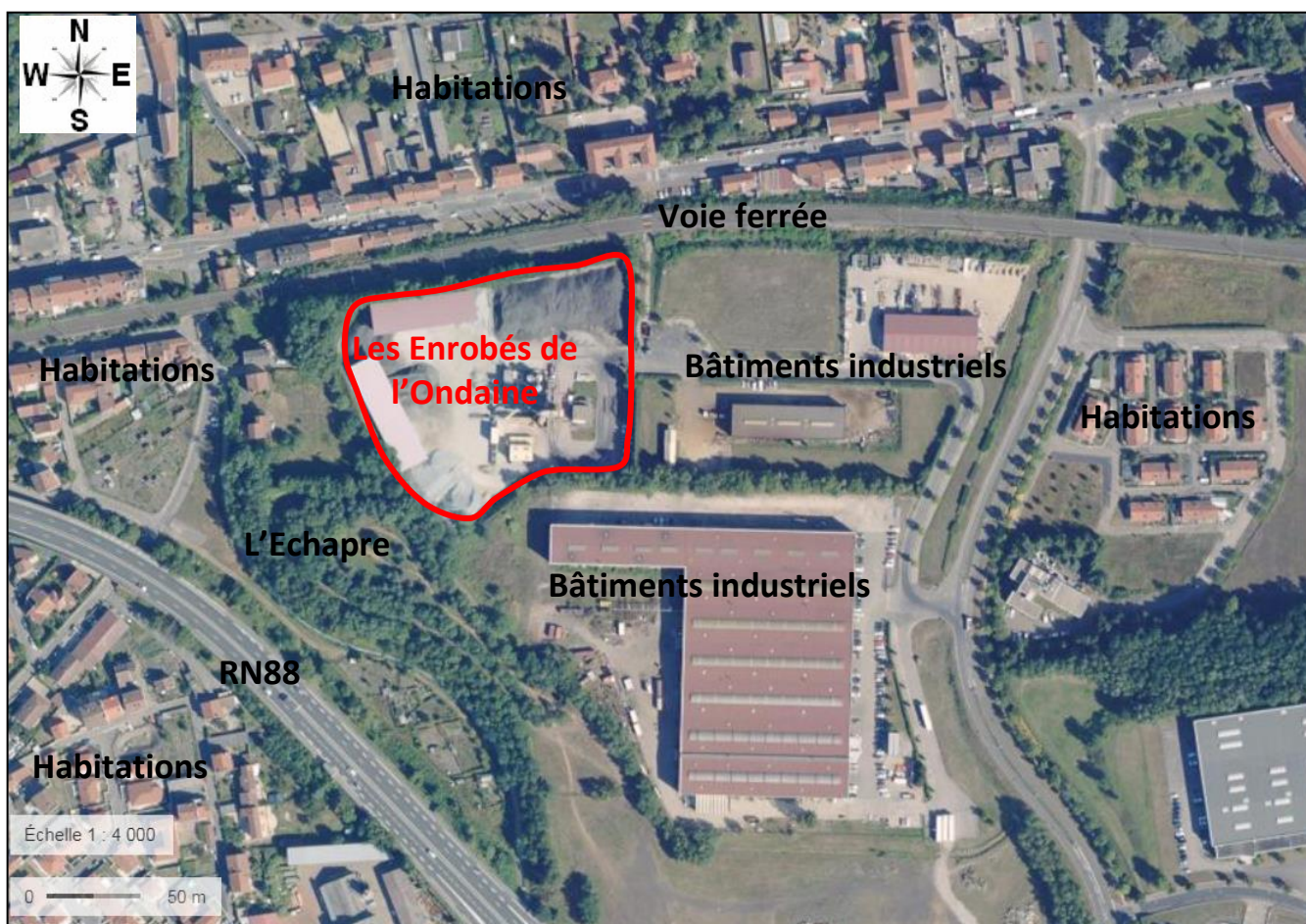
Figure 2 : Vue aérienne du site Les Enrobés de l'Ondaine
