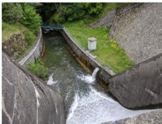
Aval barrage et restitution du débit réservé
