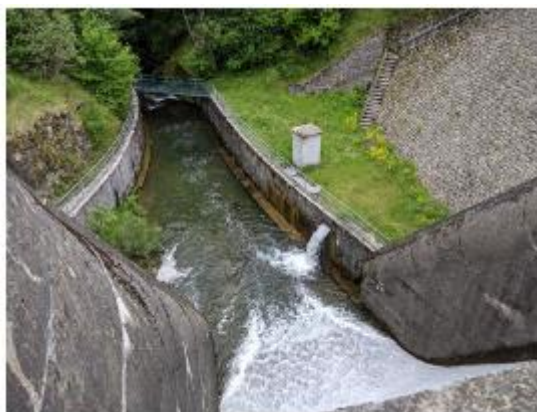
Aval barrage et restitution du débit réservé
