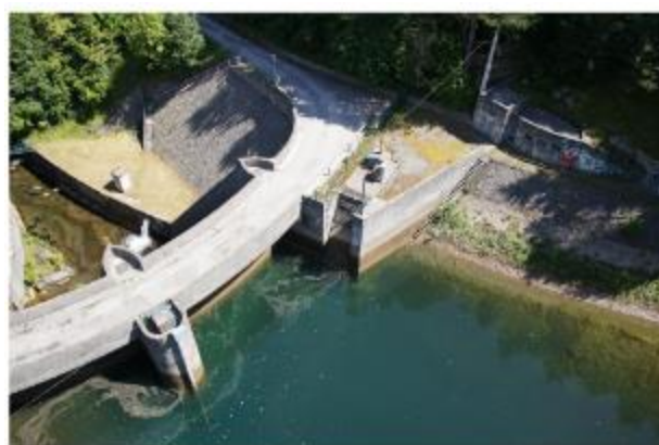
Vue aérienne du parement amont et de la prise d'eau
