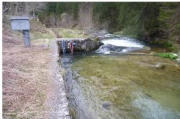
Seuil amont vue d'amont
