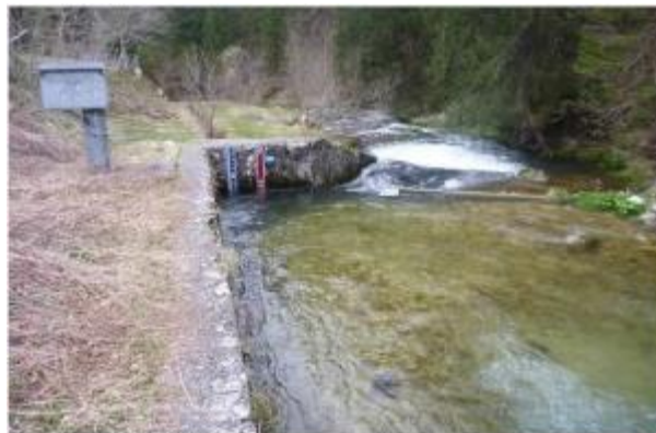
Seuil amont vue d'amont
