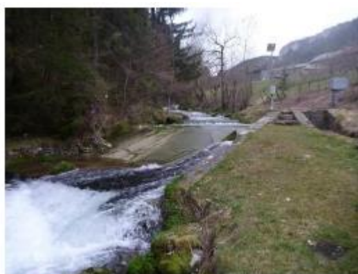
Seuil amont vue d'aval
