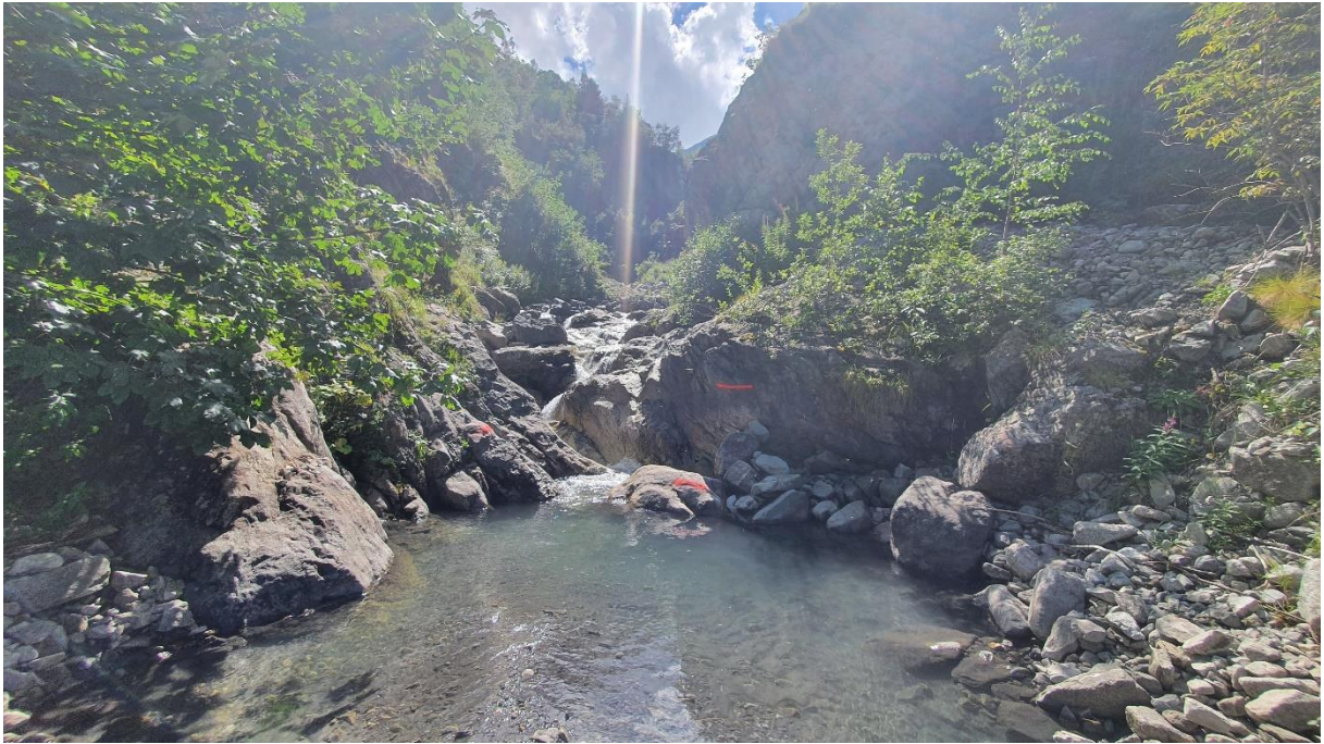
Photo 1: Vue site prise d'eau depuis l'aval le 01/09/2021
