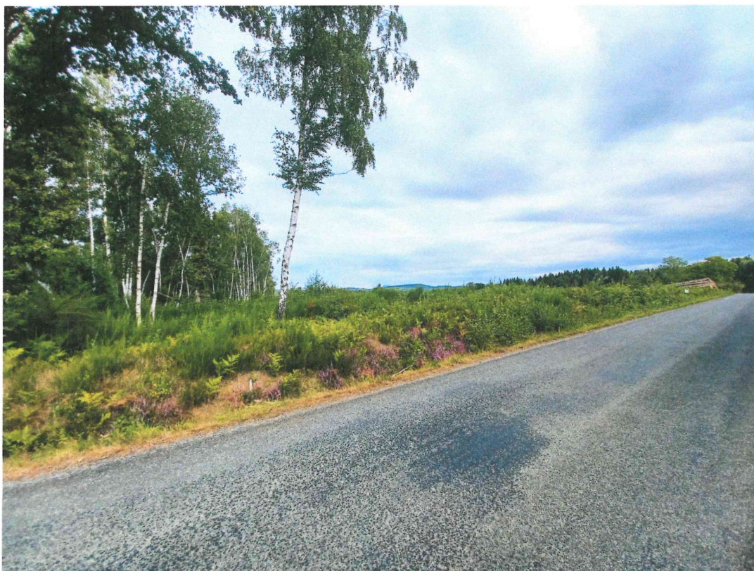
Photo n° 1 prise depuis la RD 572
