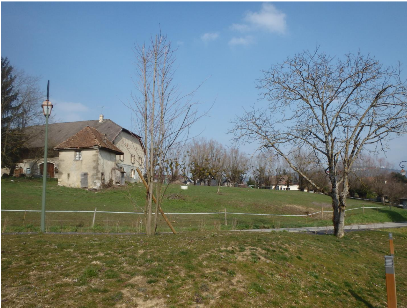
5- Vue sur le corps de ferme et l'extrémité Sud-ouest du projet depuis le cheminement piéton réalisé dans le cadre de l'urbanisation de la zone AUb2-1 au Sud du chemin de la Tour
