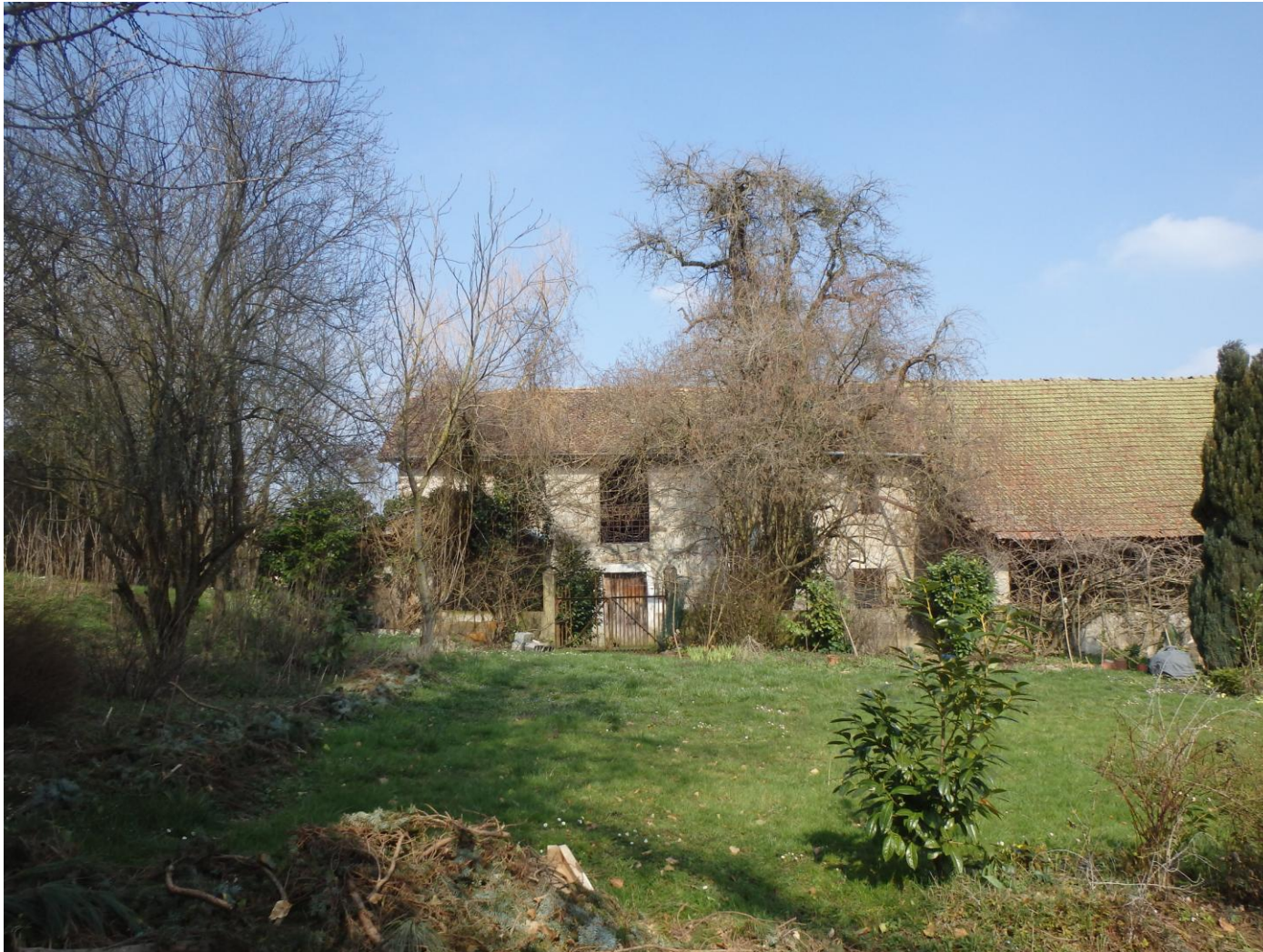
4- Vue sur les annexes de l'ancien corps de ferme
