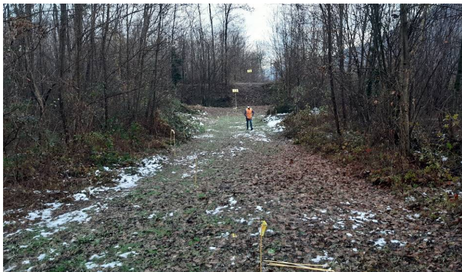
9 : Vue de l'emprise du gazoduc matérialisé par les jalons jaunes (la voie SNCF est à droite)
