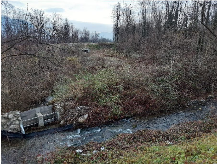
10 : Vue de l'entrée de la passe à poisson du Fay. La photographie est prise dans l'axe du tracé de l'oléoduc SPMR
