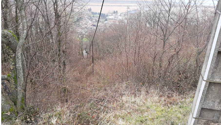
5 : Vue du début du passage de la conduite dans la zone en pente au dessus du Cheylas
