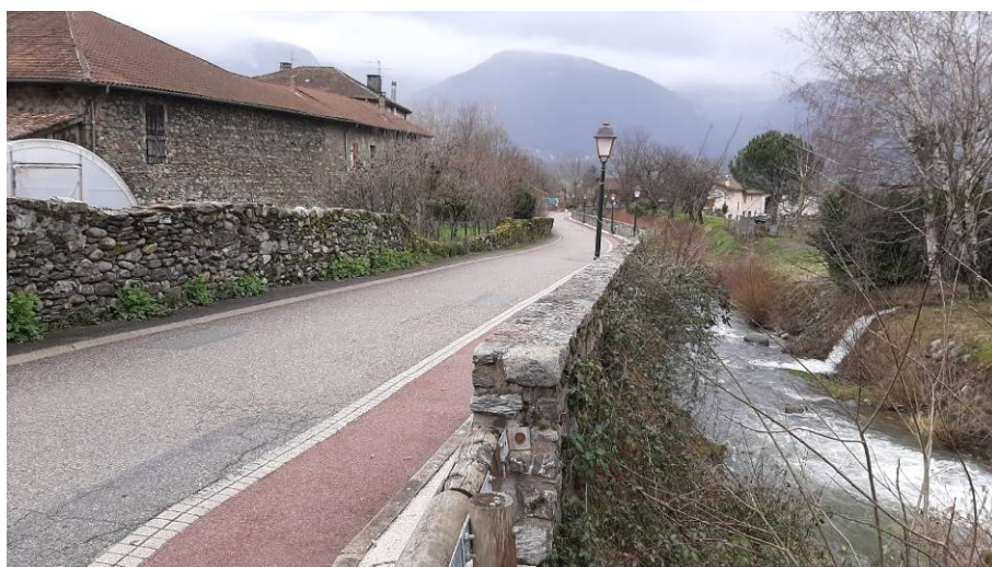
7 : Passage dans le Cheylas sous la chaussée
