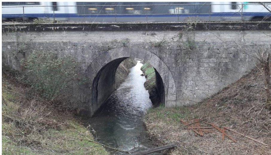
8 : Vue du passage du canal de Renevier (Chantourne) sous la voie SNCF
