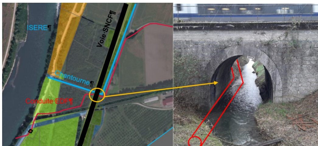
Figure 6 : Passage de la conduite sous l'ouvrage SNCF existant
