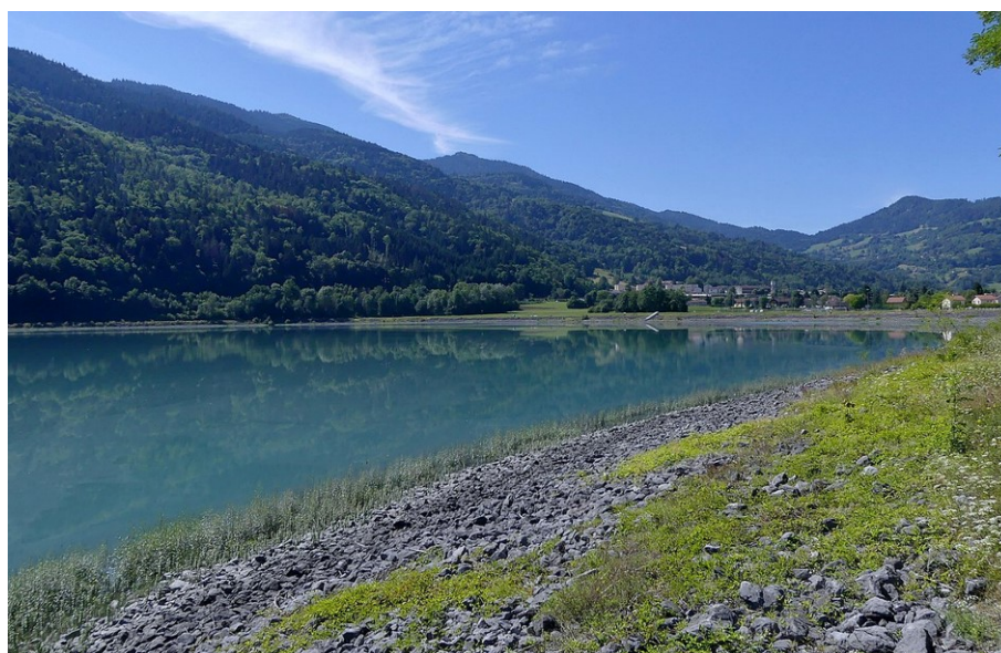
1 : Vue du bassin du Flumet depuis la rive ouest. Les installations de chantier seront sur la berge opposée
